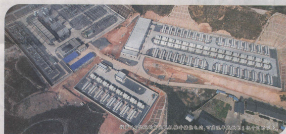
位于内蒙古阿拉善盟的某储能电站,可存储电量达1.4亿千瓦时。
